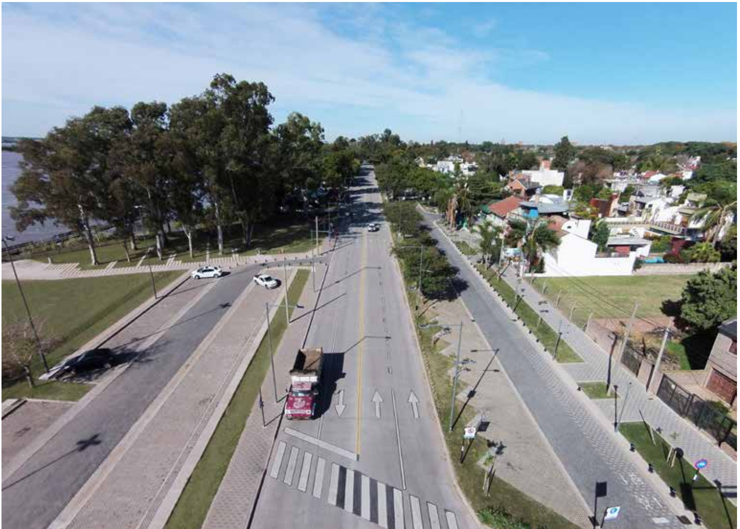
Foto Remodelación Av. Carrasco, Rosario. Fuente: Archivo ECOM, Junio 2019
