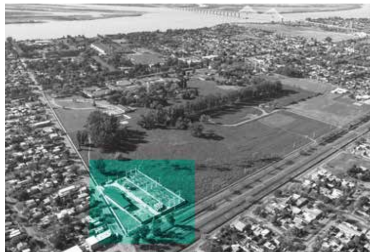
Estación Termotransformadora Granadero Baigorria, Empresa Provincial de la Energía. Fuente Archivo ECOMR, Oct. 2018
