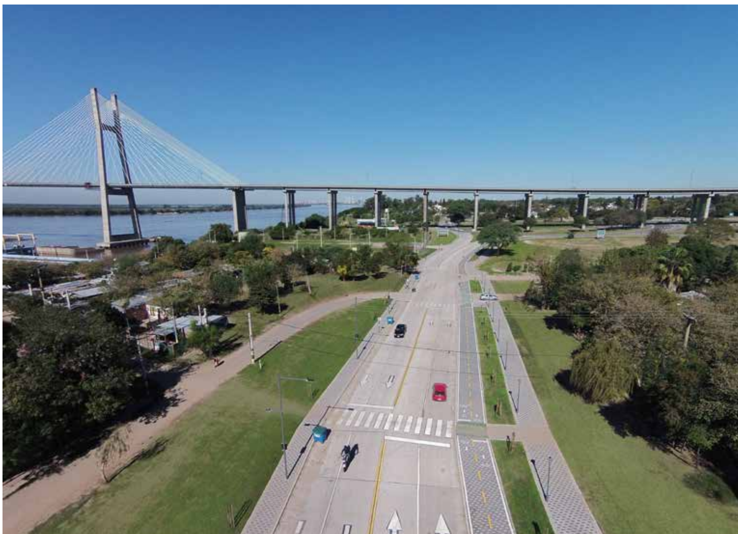
Foto Construcción Av. Los Plátanos, Granadero Baigorria. Fuente: Archivo ECOM. Junio 2019
